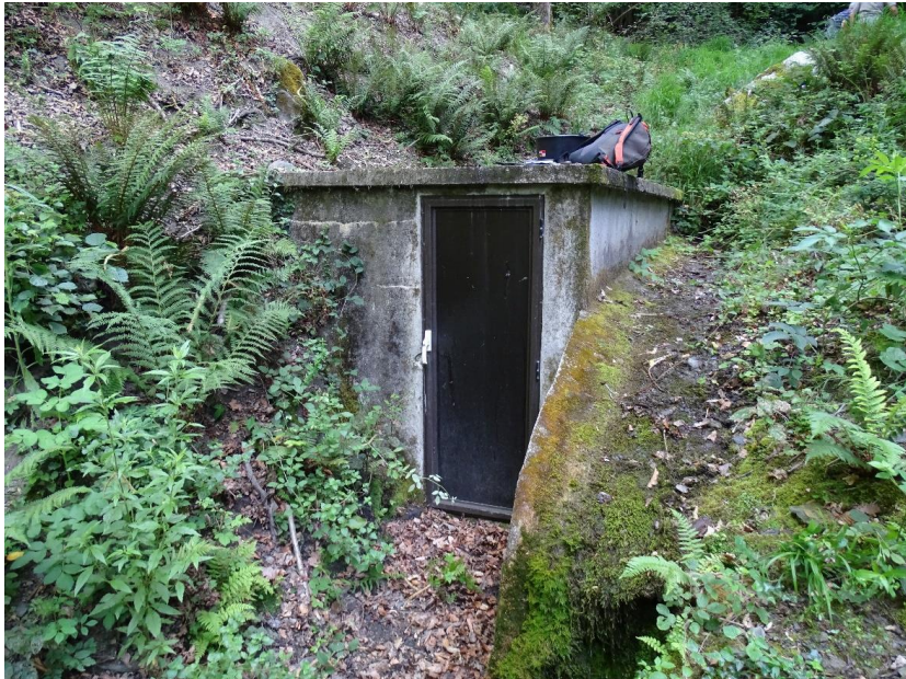
Illustration 4 : l'abri maçonné au-dessus du captage vu côté sud (source SMDEA)
